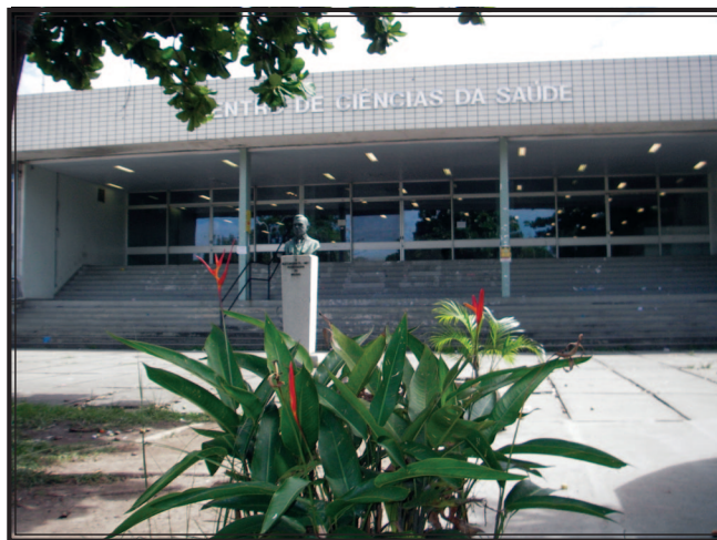
Entrada principal do Centro de Ciências da Saúde da URFJ na Ilha do Fundão. (Foto Hermann Schatzmayr)
