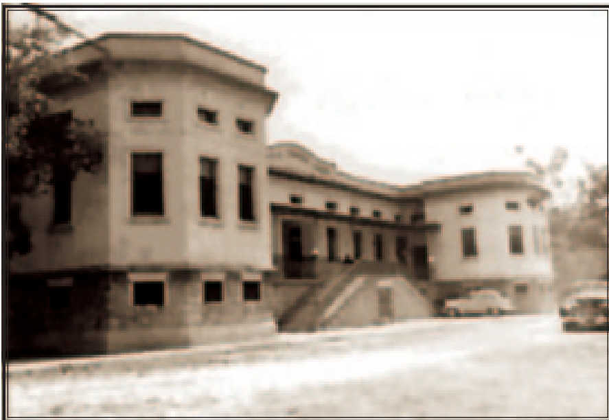
O prédio tombado do Hospital de Manguinhos, construído segundo projeto de Oswaldo Cruz é hoje parte do IPEC na Fiocruz, RJ
